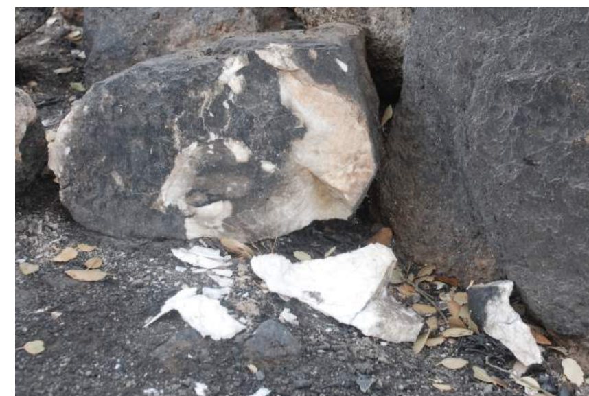
Cuarcita: daños por altas temperaturas tras incendio forestal
